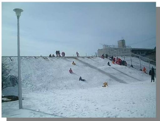
高砂下水処理センター最初沈殿池の上部利用
