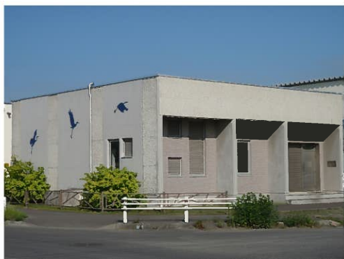
明野中継ポンプ場
