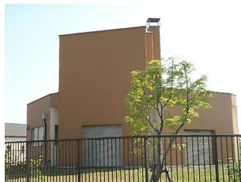
錦岡中継ポンプ場
