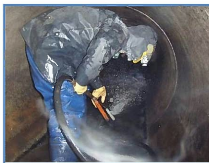
管渠内清掃状況
