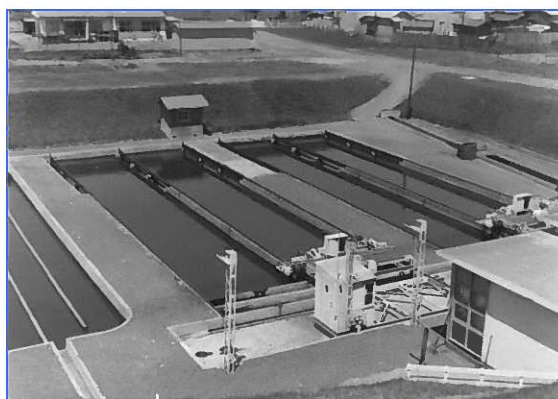
昭和34年 浜町処理場
