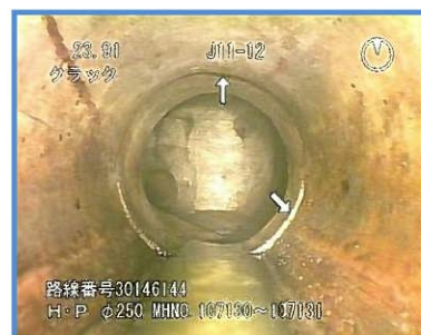
既設管渠の状況(カメラ調査結果)
